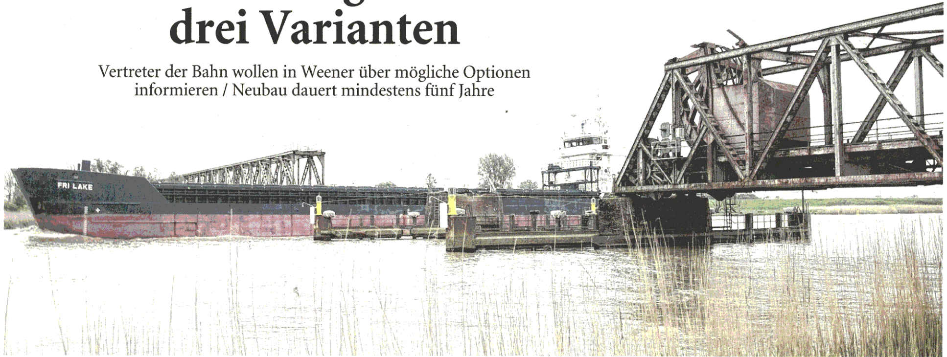
Ein Frachter fährt durch die Lücke in der Friesenbrücke. Wie ein Wiederaufbau des Bauwerks in der Ems bei Weener aussehen könnte, darüber will die Deutsche Bahn am 2. Juni die Öffentlichkeit informieren. Foto: Hanken
