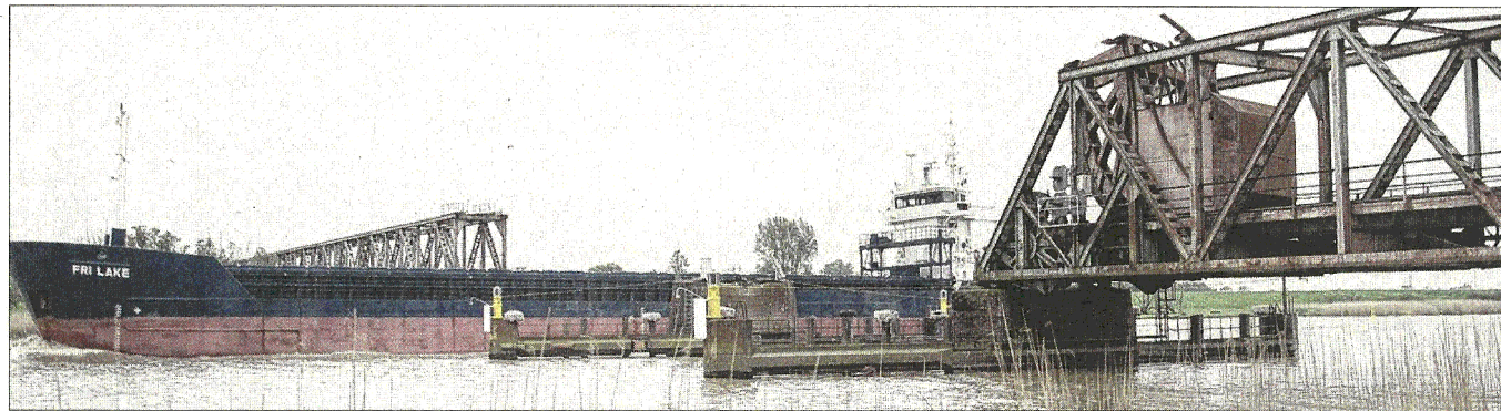
Seit Dezember vergangenen Jahres steht die Brücke als Ems-Überquerung nicht mehr zur Verfügung.
