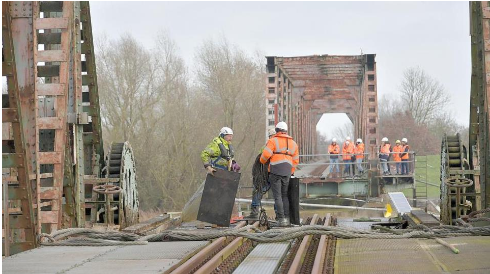
Am Donnerstag wurde der erste Versuch unternommen, das Brückenteil zu heben. Foto: Ortgies
