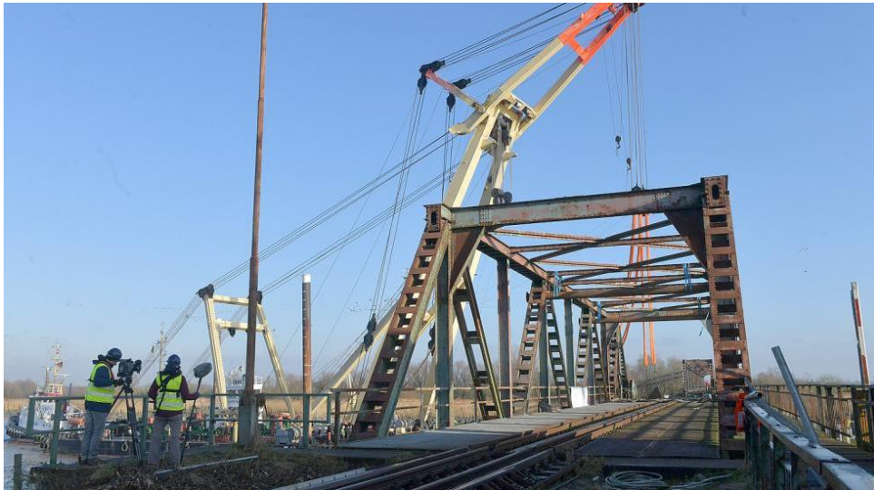
Die Abrissarbeiten an der Friesenbrücke wurden an diesem Donnerstag fortgesetzt. Foto: Ortgies
