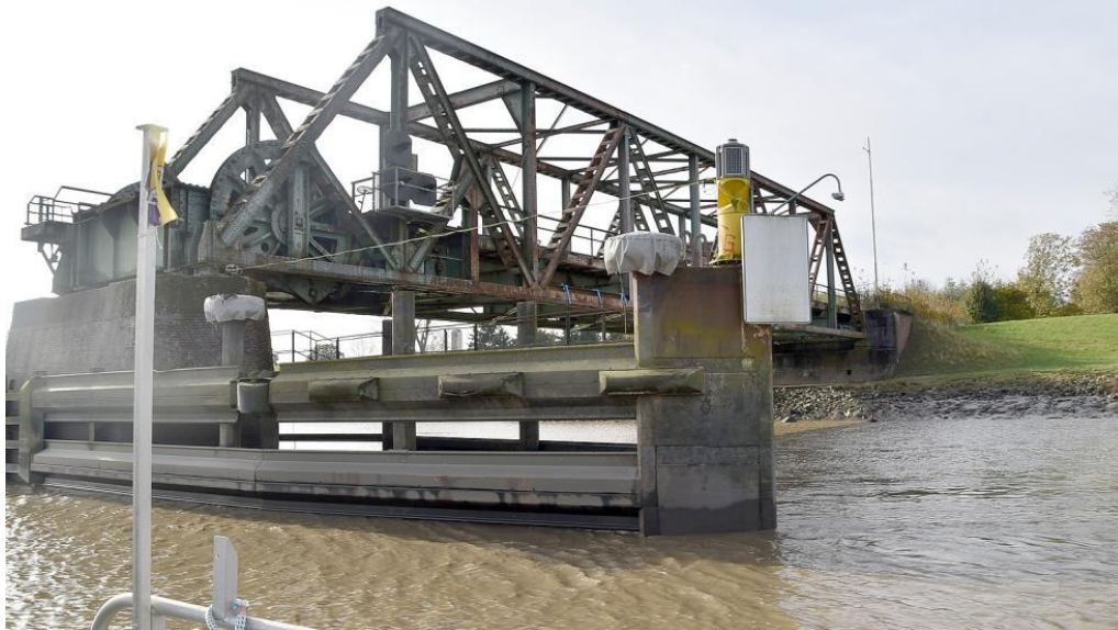
Mit Hilfe eines speziellen Schwimmkrans sollen die Eisenbahnbrückenteile herausgehoben werden. Foto: Ammermann
