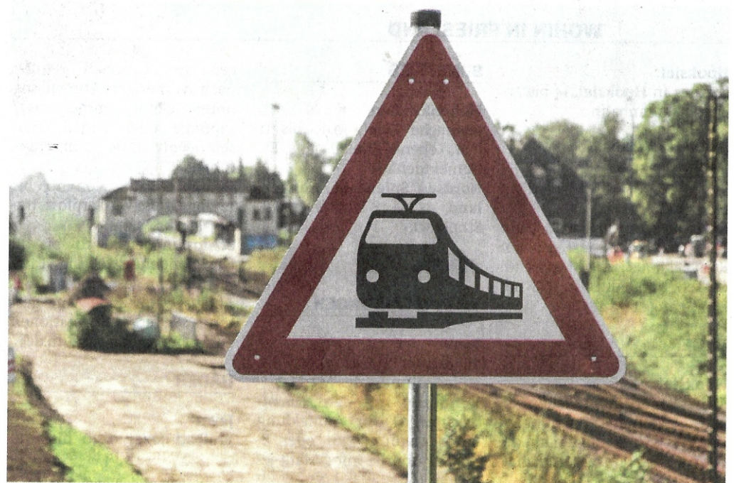
Seit zwei Jahren Baustelle und nicht mehr wiederzuerkennen: Ab dem 25. Juli kehrt am Sander Bahnhof wieder etwas mehr Normalität ein. Ein Bauwerk steht noch aus. FOTO: WZ-BILDDIENST
